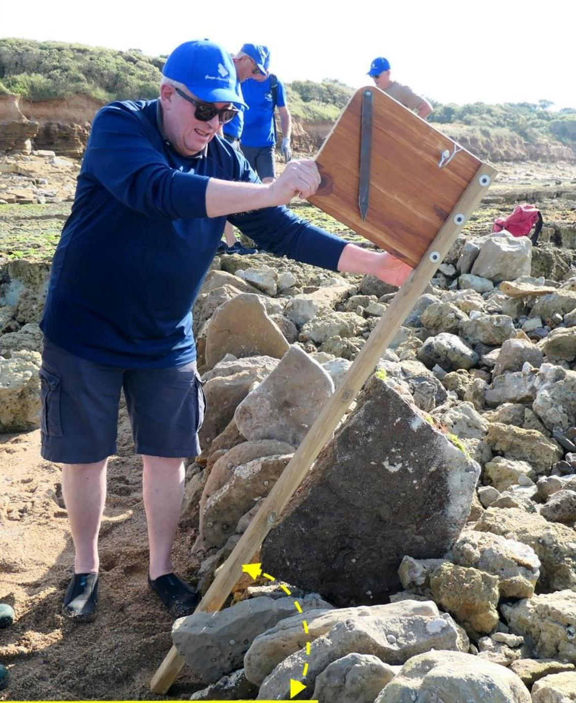
l'outil adapté permet de vérifier l'angle des pierres
