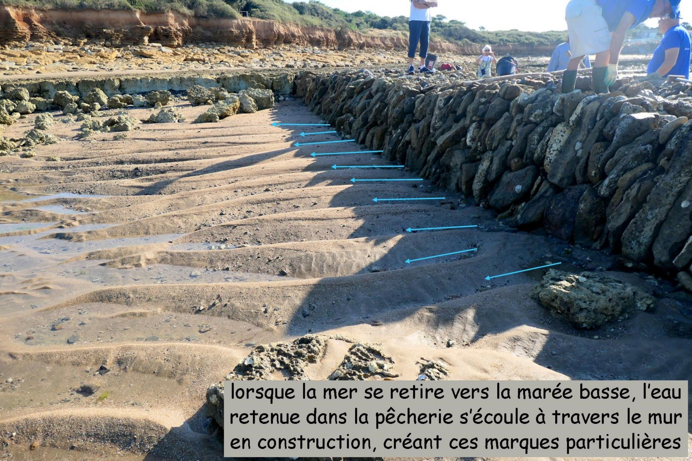
lorsque la mer se retire vers la marée basse, l'eau retenue dans la pêcherie s'écoule à travers le mur en construction, créant ces marques particulières
