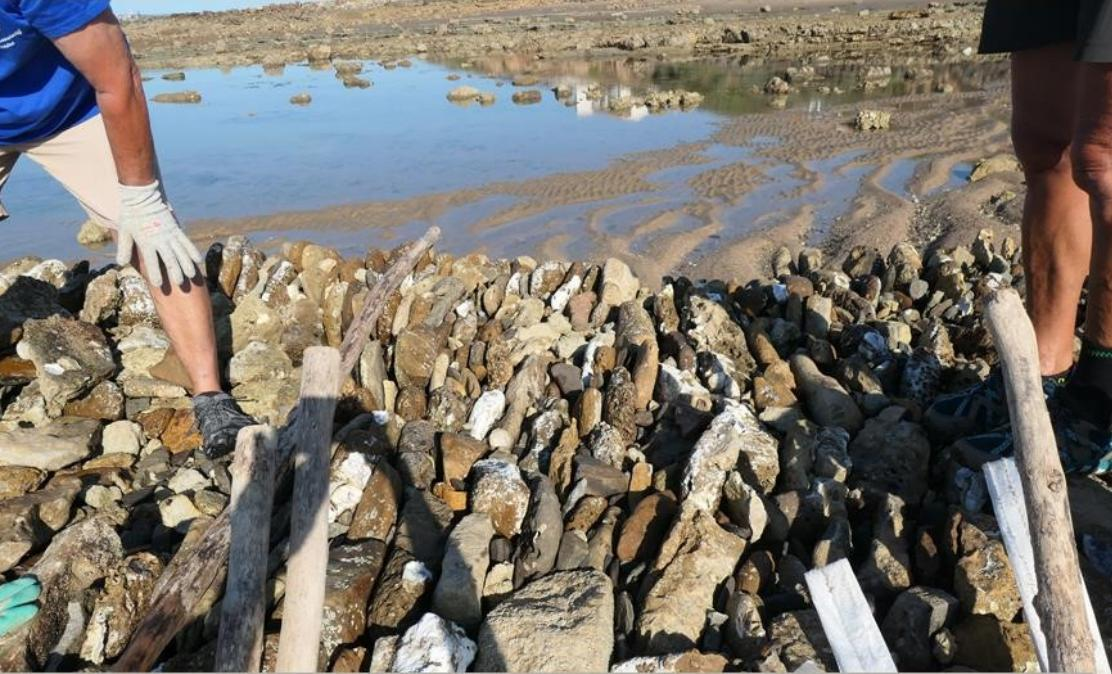
encore une réalisation précise: caler les pierres du dessus du mur
