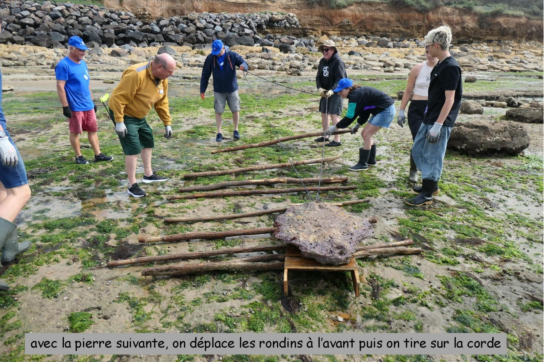
avec la pierre suivante, on déplace les rondins à l'avant puis on tire sur la corde
