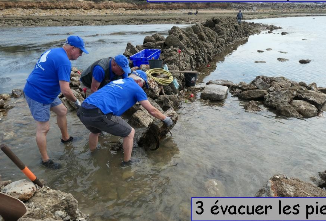
2 vérifier le bon positionnement des pierres support du vidage
