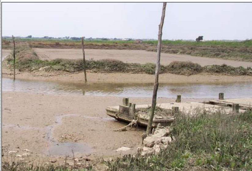
Lasse bois de 8 m. détruite lors de la tempête Xynthia (construction de 1970)
