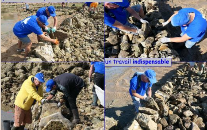
positionner les pierres pour monter le mur :
