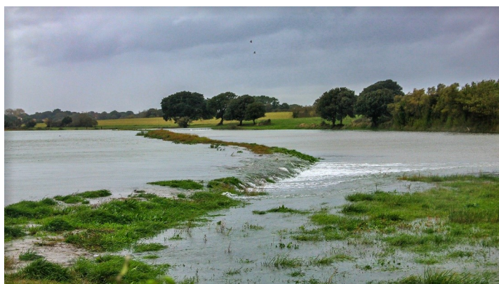
Des digues submergées... (Vers le pont du Veillon - crédit photo Talmondaï.com)
