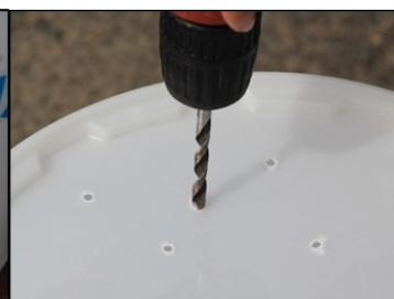
Faire des trous dans le couvercle pour aider à la sortie de l'eau et fixer les flotteurs.
